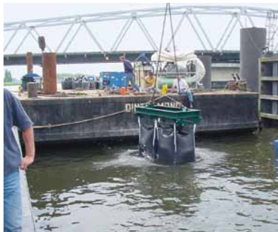
Omgevingsmanagement draagt bij aan minder hinder: snelle reparatiemethode van de bodembescherming in het kanaal van Gent naar Terneuzen.
