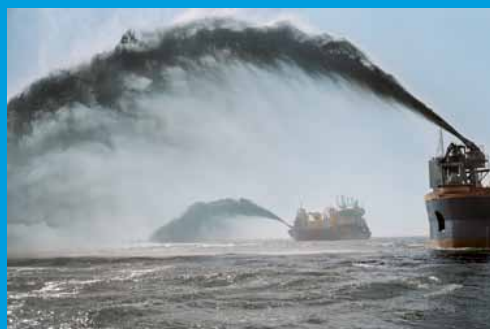
Rainbow-methode Maasvlakte 2: aanleg nieuw land in zee biedt nieuwe kansen voor natuur(compensatie).
